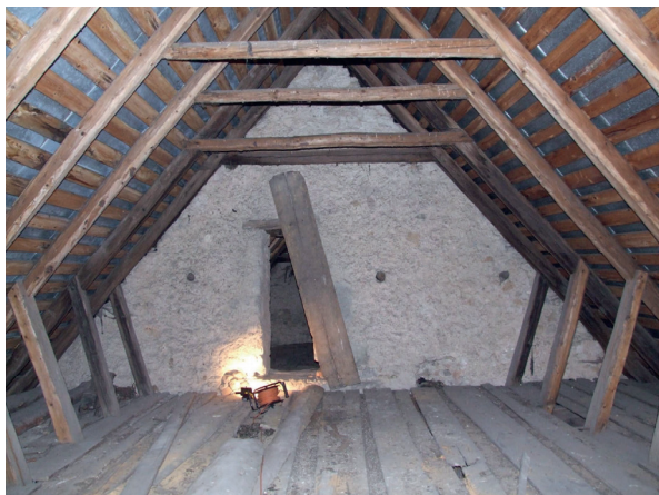
Obr. 18: Abramová, Kostol sv. Kozmu a Damiána, krov nad loďou (prelom 15. a 16. storočia) – jednoduchá krokrová konštrukcia krovu bez pozdĺžneho viazania.
