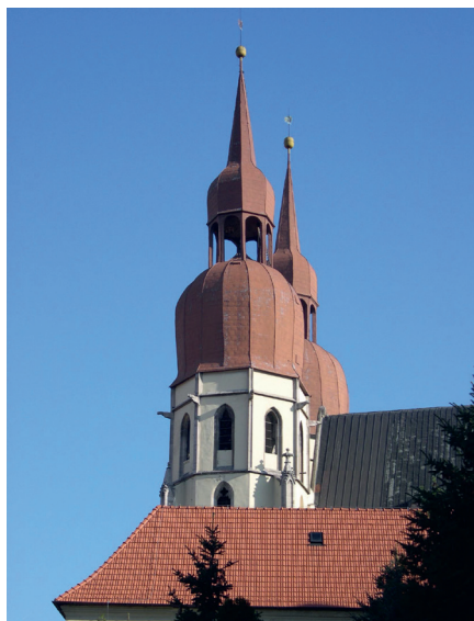
Obr. 8: Trnava, Bazilika sv. Mikuláša – dvojstupňové helmicové strechy veží s otvorenými lucernami (16. storočie).
