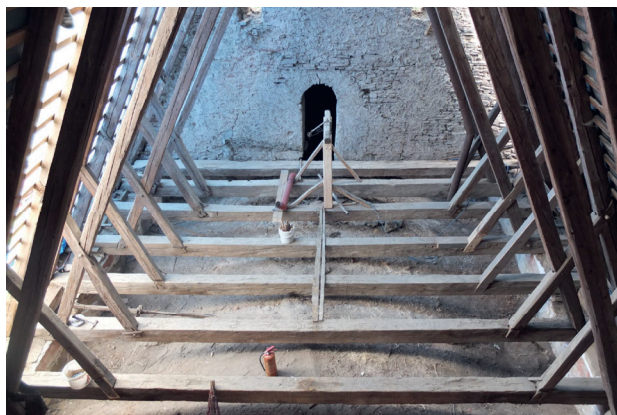
Obr. 9: Raslavice, Evanjelický kostol a. v., krov (60. roky 15. storočia) – vážné trámy.
