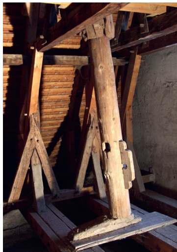
Obr. 31: Bardejov, Radnica – zachovaná časť pôvodného ťažného zariadenia v podkroví (vertikálny vrátok).
