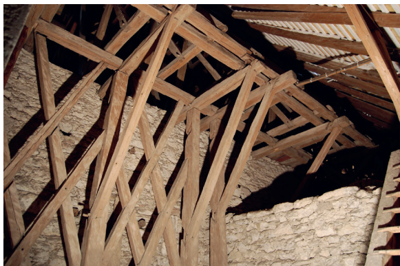
Obr. 28: Spišská Kapitula, Kostol sv. Martina, krov nad loďou (60. roky 15. storočia) – zachovaná časť rámu pôvodnej drevenej podpornej konštrukcie, na ktorú bol postavený krov ešte pred domurovaním medzilodných múrov.
