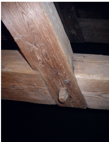
Obr. 7: Okoličné, kláštorňý kostol, krov nad loďou (90. roky 15. storočia) – rybinové plátovanie zaistené dreveným kolíkom.
