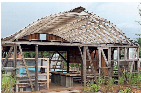
Obr. 21: Coburg (Nemecko), obytný dom – lamelový krov typ Zollinger (1920).
