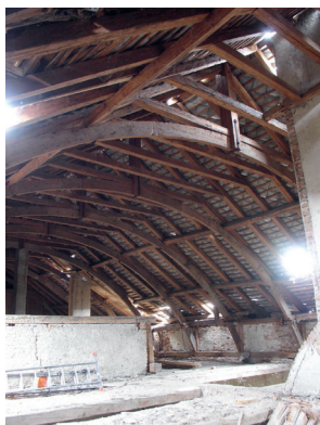
Obr. 20: Hubice, kaštieľ – skružový krov typu Delorme (30. roky 19. storočia).
